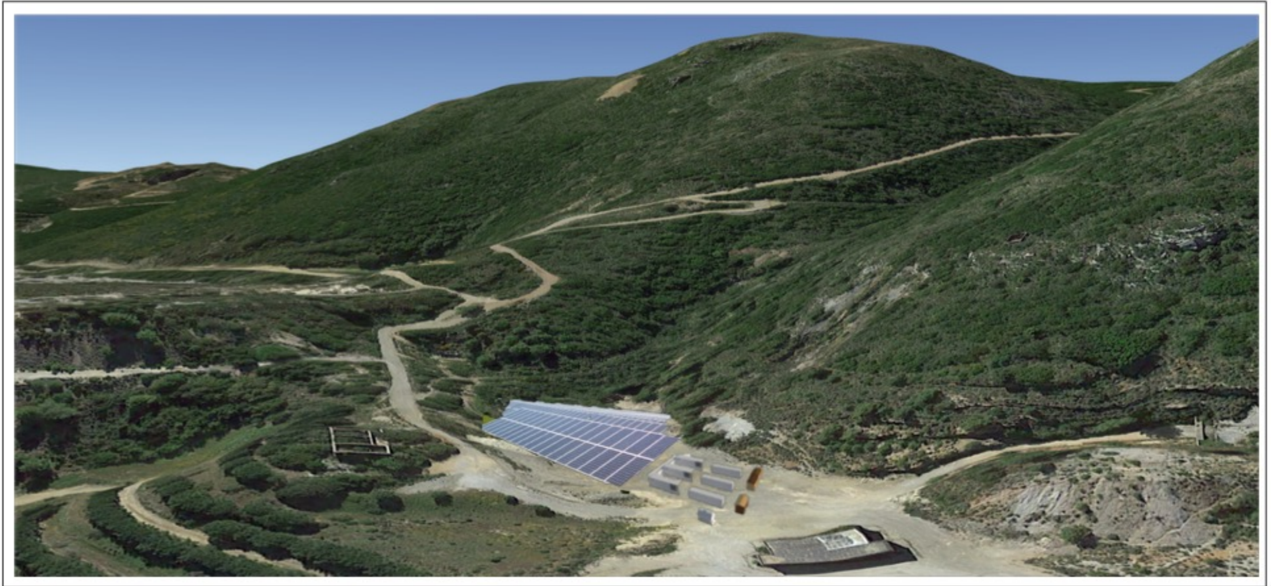
Piazzale – impianto fotovoltaico, stazione di energia e chiller
